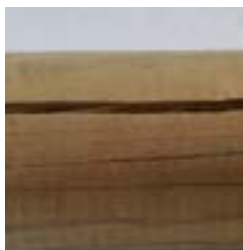
Cracks/Grietas/Fente/Risse/ Crepe/ Barsten/Fendas
