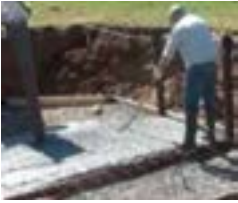
Construction of the concrete slab Construcción de la losa de hormigón Réalisation de la dalle béton Bau der Betonplatte Realizzazione del basamento di calcestruzzo Constructie van de betonplaat Construção da laje em betão
