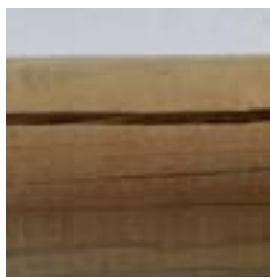
Cracks/Grietas/Fente/Risse/ Crepe/ Barsten/Fendas
