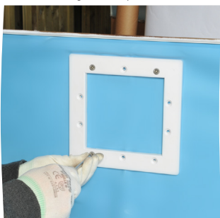
Avvitare il traversino e togliere il liner
