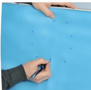
Individuare e segnalare la posizione delle viti
