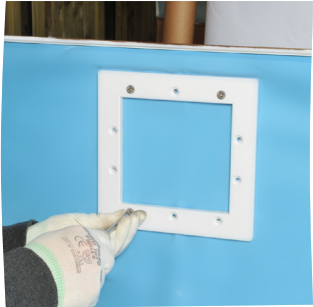
Atornille la brida y ahueque el liner
