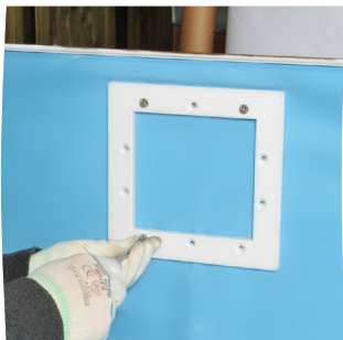
Aparafuse o flange e aligeire o liner
