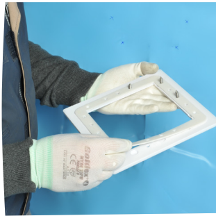
Plaats het verbindingsdeel op de flens
