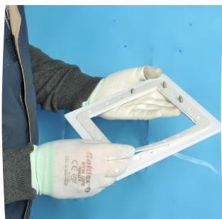
Coloque a junta sobre o flange
