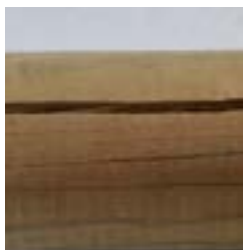
Cracks/Grietas/Fente/Risse/ Crepe/ Barsten/Fendas
