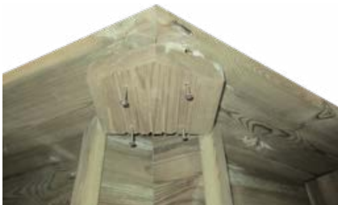
Fixing of the plates Fijación de los tacos bajo las placas Fixation de la plaque sous margelles Befestigung der Platten unter den Rändern Fissaggio delle piastre sotto i bordi Bevestiging van de platen onder de randen Fixação das placas sob os bordos
