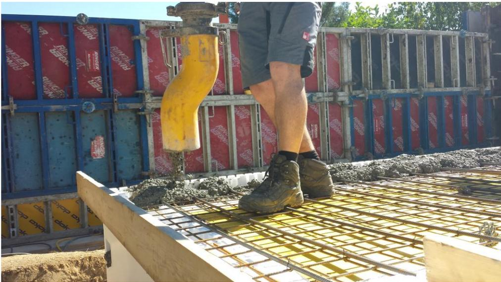
Nach der Befüllung werden die Wände sofort ausgerichtet (Alulatte oder Schnur). Kontrollieren Sie die Beckenmaße. Sie haben ca. eine halbe Stunde Zeit um kleine Abweichungen auszugleichen indem man vorsichtig gegen die Wand drückt und diese mit Kanthölzern und Brettern ggf. abstützt.
