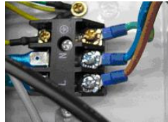
Abbildung 9: Klemmen für den Anschluss an das Stromnetz.
