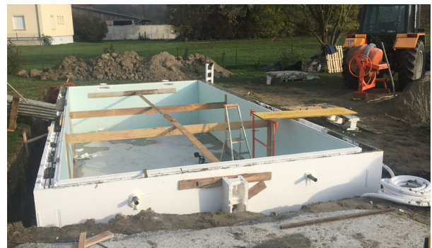
Versteifung der Poolwände vor der Befüllung
